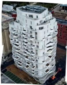
Marquette (lez Lille) (59), sur site Grands Moulins de Paris : 49 jardinières préfabriquées, chantier intégrées au coulage. Singularité des balcons : dimensions, rayons de courbures et non-superposition d'étage en étage.
